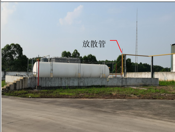
图 9 LNG 气化站
