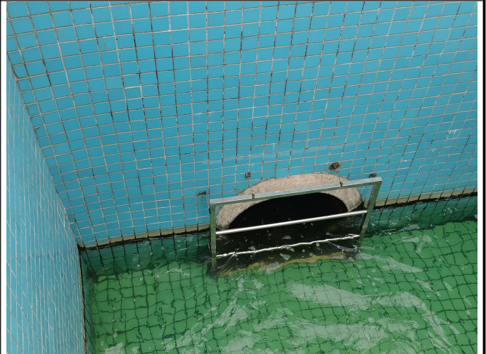
图片 14 与一期共用出水口
