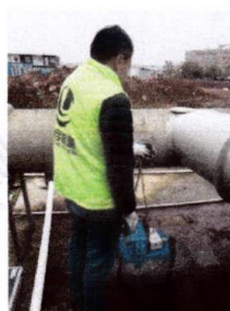
污水处理设施恶臭、除臭间废气处理前
