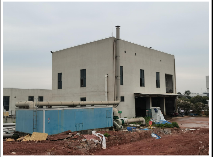
图片 11 依托的生物除臭装置和排气筒
