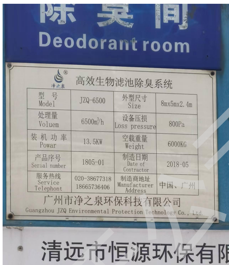
图 7.1-2 现有生物除臭塔设计参数
