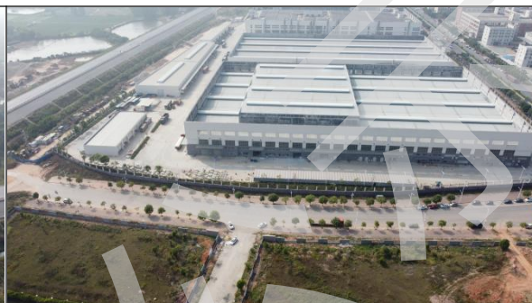
图片 3 现有项目南侧为欧派橱柜
