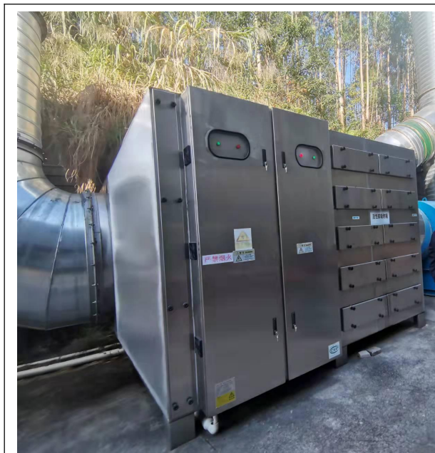
图 1 静电式烟雾净化设备+活性炭吸附
