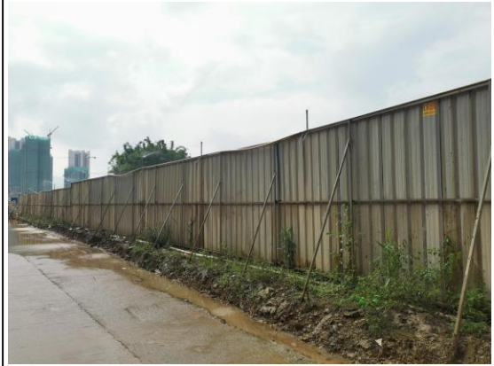
图片 6 施工临时围挡
