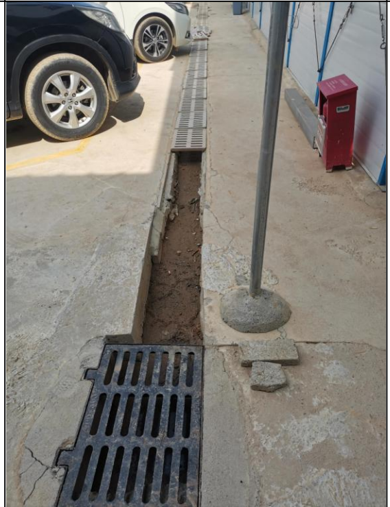
图片 6 污水水渠
