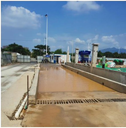
图片 5 施工车辆洗车槽
