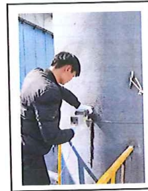
1#、2#、3#发泡炉，1#、2#、3#、4#压纹机废气排放口 FQ-ORO513-7
