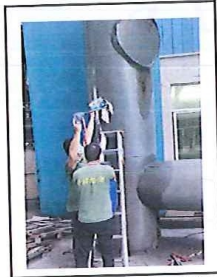
1#、2#、4#、5#开布机、6#-10#表面处理废气处理后
