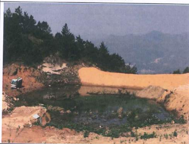
雨水收集池-用于道路洒水抑尘
