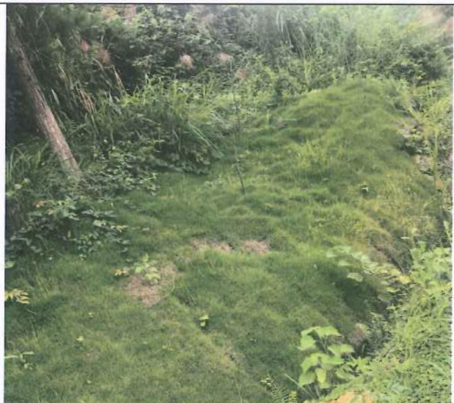
施工结束后沿途复绿情况
