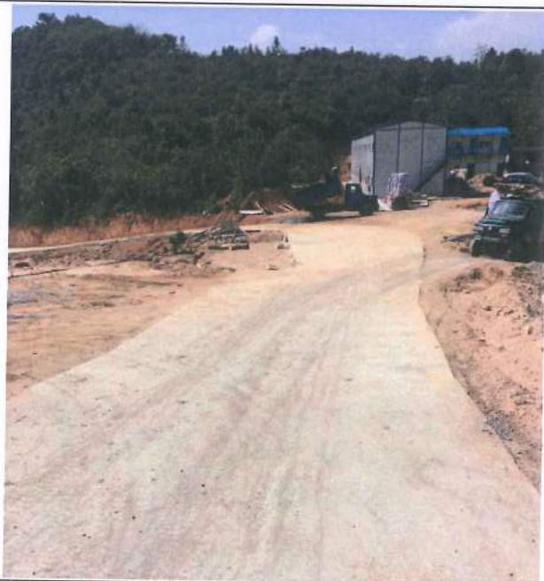
厂区内道路硬底化
