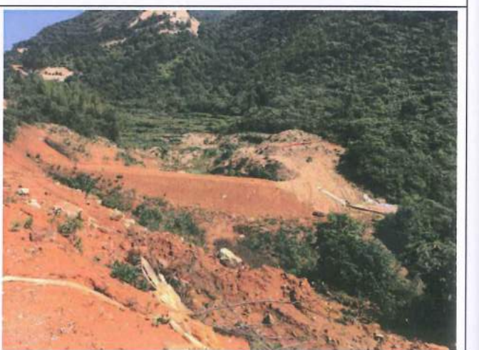
拦泥坝建设情况-底部为混凝土
